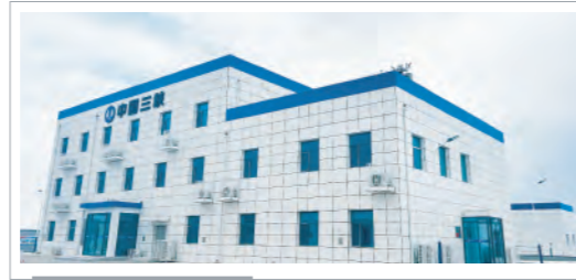
内蒙古乌兰察布180MWh绿色电站示范项目 Ulanqab 180MWh Green Power Station Demonstration Project
