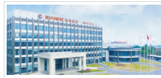
浙江仙鹤新能源有限公司44.72MWh储能项目 Zhejiang Xianhe New Energy Co., LTD. 44.72MWh Energy Storage Project
